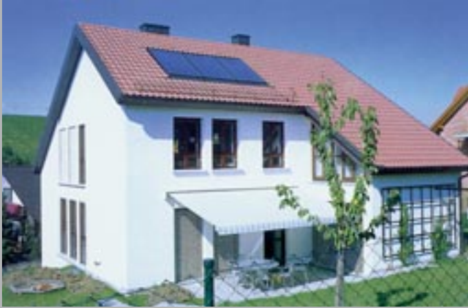
Ejemplo de instalación solar térmica integrada arquitectónicamente en el edificio
